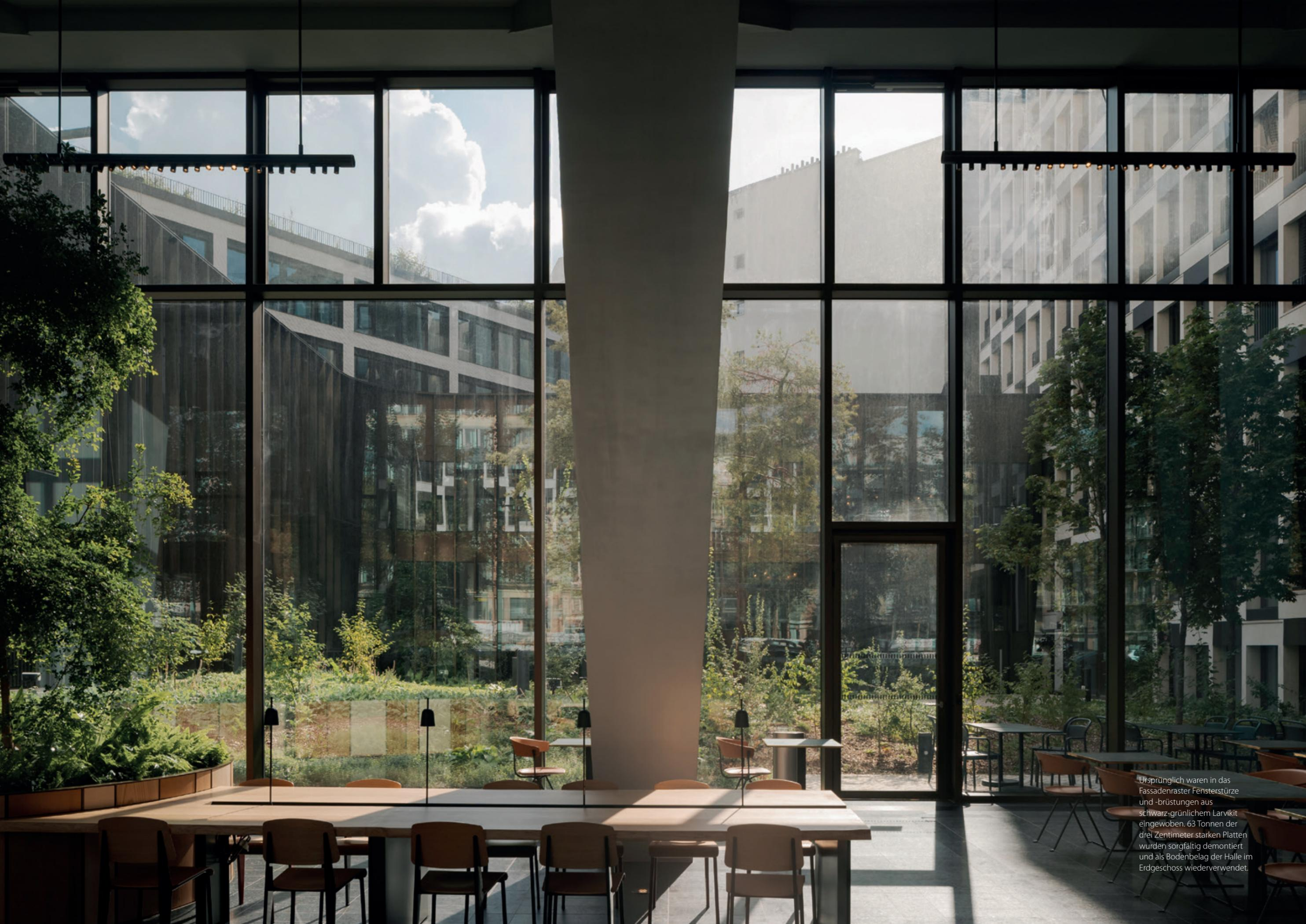
Ursprünglich waren in das Fassadenraster Fensterstürze und -brüstungen aus schwarz-grünlichem Larvikit eingewoben. 63 Tonnen der drei Zentimeter starken Platten wurden sorgfältig demontiert und als Bodenbelag der Halle im Erdgeschoss wiederverwendet.
