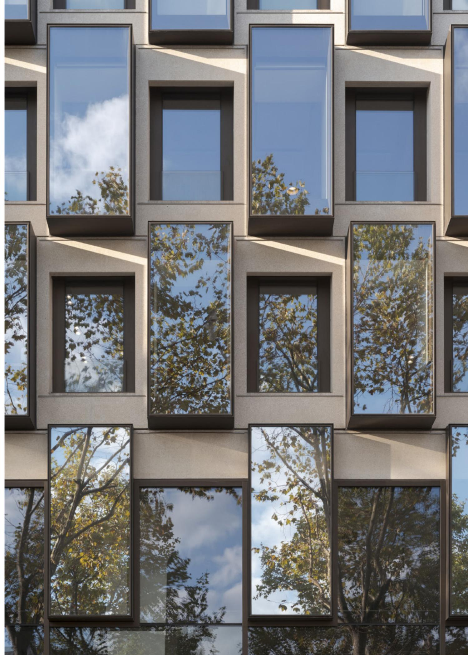
Prägendes Element der bestehenden Fassade sind rasterartig angeordnete Module aus weissen Betonrahmen von 3,20 x 1,50 Metern, in denen die Fenster sitzen. Diese Rahmen wurden Hunderte Male wiederholt und kamen auch an den Fassaden zum Hof zum Einsatz. Sie konnten weitestgehend original erhalten werden.
